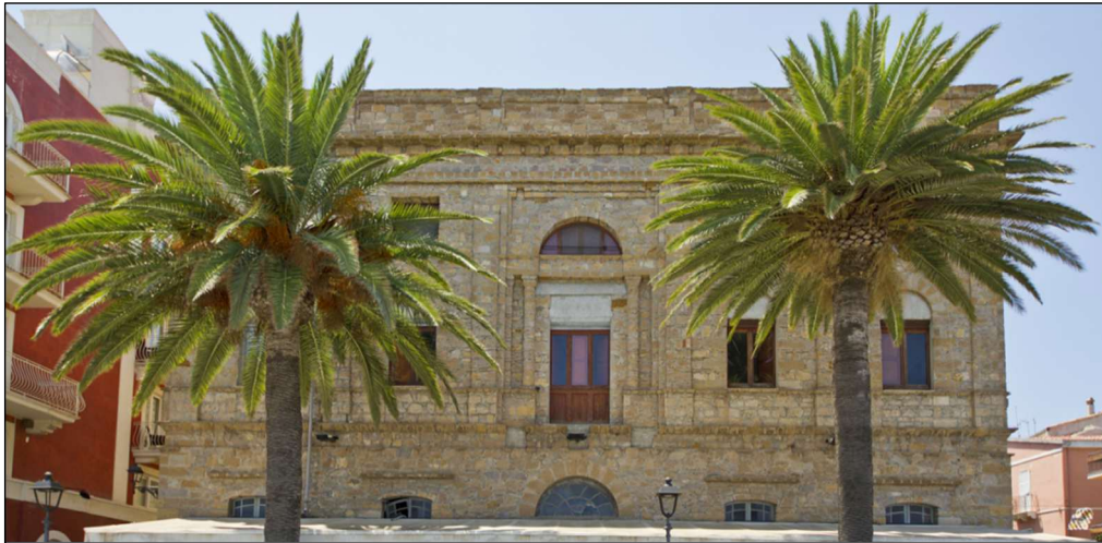
Figura 23. Facciata del Cineteatro Cavallera.
