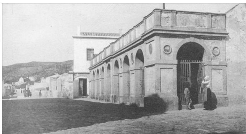
Figura 11. Il Cisternone (foto degli inizi del '900)
